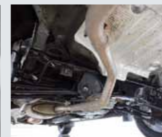
Výfuk vedený pod nápravou je v těžším terénu zranitelný
