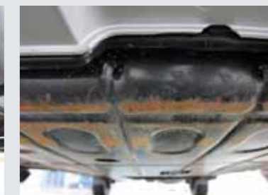
Plechový kryt pod motorem se jen tak neulomí, korozi však padláhá rychle
